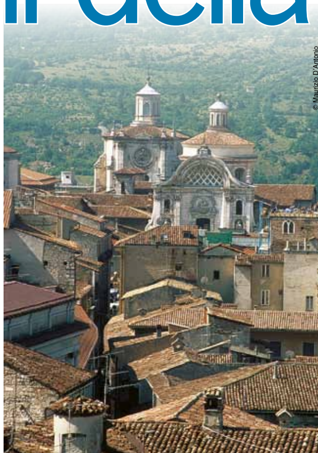
Uno scorcio del centro storico, dai tetti di corso Vittorio Emanuele II, che anticamente costituiva la via principale della città.
